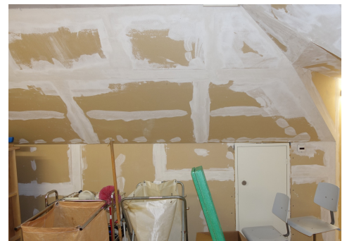
Spachtelmasse auf Gipskarton vor Verputz (hier ohne Asbest). Photo Carbotech AG
