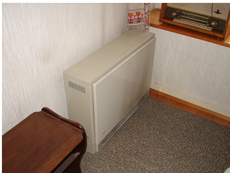
Elektrospeicherofen mit Asbest in geschlossenem Zustand. Photo Carbotech.
