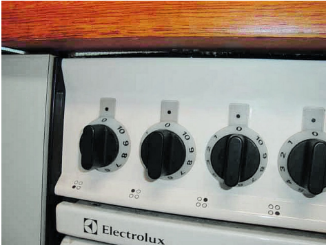
Asbestband bei Kochherd
