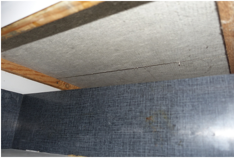
Leichtbauplatte unter Kocheherd, Carbotech
