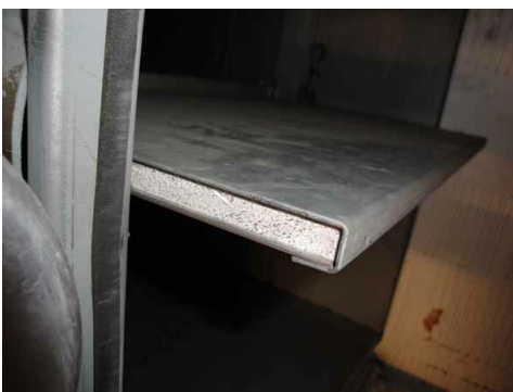
Brandschutzklappe mit Klappenblatt mit Leichtbauplatte, Carbotech
