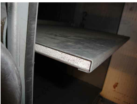
Brandschutzklappe mit Klappenblatt mit Leichtbauplatte, Carbotech
