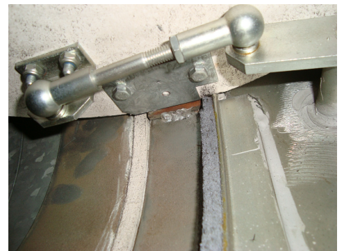
Anschlagdichtung Litaflex in Brandschutzklappe Nahaufnahme, Carbotech
