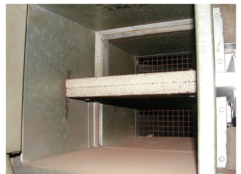
Brandschutzklappe mit Litaflex-Anschlagdichtung, Carbotech
