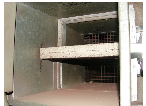
Brandschutzklappe mit Litaflex-Anschlagdichtung, Carbotech
