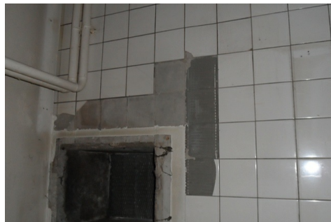
Fliesenkleber mit Asbest - hinter den gleichen Fliesen können sich verschiedene Kleber verbergen. Stephan Baumann, Bafob
