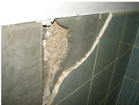
Dickbett-Fliesenmörtel gilt nach gegenwärtigem Stand des Wissens ebenfalls als nicht asbestverdächtig. Eine Ausnahme bilden in seltenen Fällen Dickbettkleber mit feinem eher dunklen Gemisch (einzelne Sand-Kerne sind nicht sichtbar). Photo: Carbotech AG.
