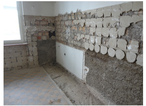
"Mörtelbatzen" gelten nach gegenwärtigem Stand des Wissens als nicht asbestverdächtig und müssen somit nicht beprobt werden. Photo: Carbotech AG.
