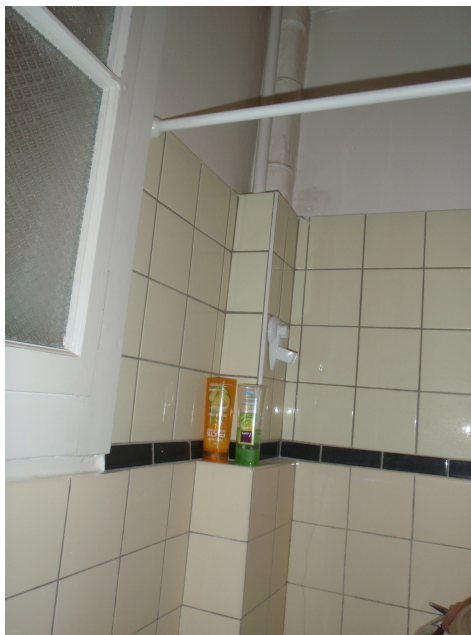
Erneuerte Fliesen über einer Badewanne, SCS
