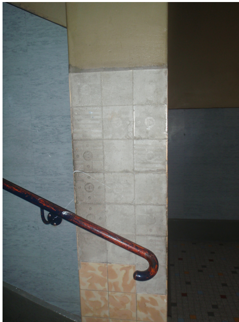
"Mörtelbatzen" gelten nach gegenwärtigem Stand des Wissens als nicht asbestverdächtig und müssen somit nicht beprobt werden. Photo: Carbotech AG.
