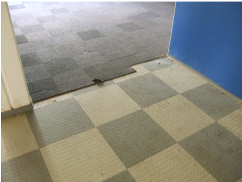
Vinyl-Platten mit Noppen (hier asbestfrei)
