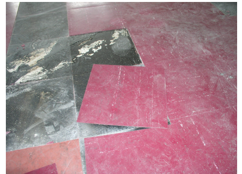
Rote Floorflexplatten mit bituminösem Kleber, Suva
