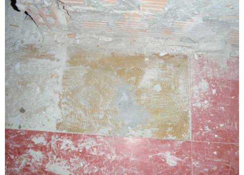
Nicht-bituminöser-Kleber von Vinyl-Platten
