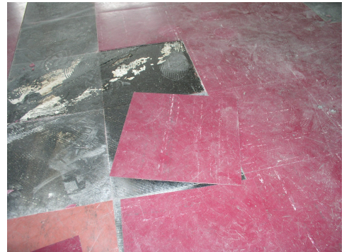
Rote Floorflexplatten mit bituminösem Kleber, Suva
