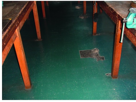
Floorflex grün mit bituminösem Kleber, Suva
