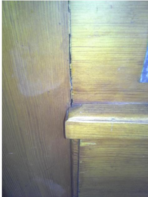
Photo Spachtelmasse mit Asbest auf Holz.
