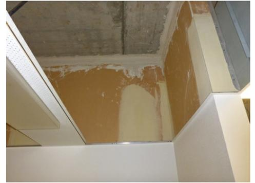
Spachtelmasse mit Asbest. Einbau in den 70er-Jahren. Photo Carbotech AG.
