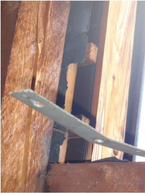
Bitumen-Pappe (in diesem Fall ohne Asbest)
