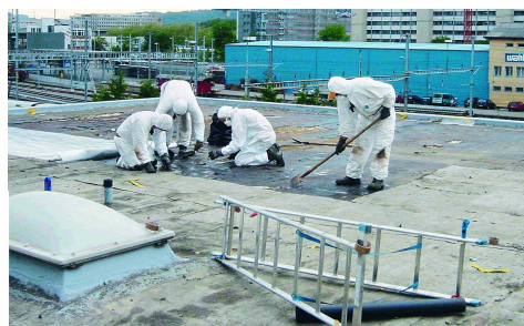
Asbesthaltige Bitumenbahn, Suva
