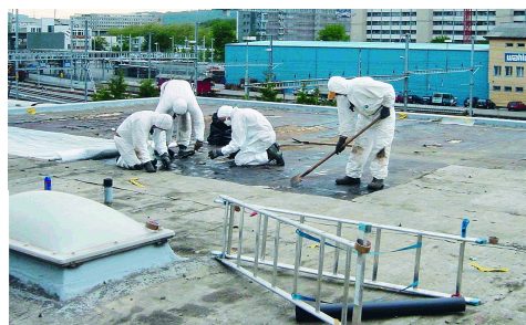
Asbesthaltige Bitumenbahn, Suva
