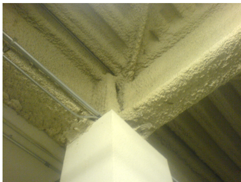
Spritzisolierung als Brandschutz - in diesem Fall ohne Asbest (neueren Datums)
