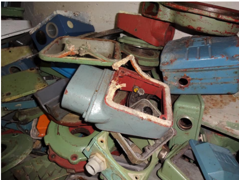
Asbestschnur in alter 500 Volt Steckdose. Photo: J. Meyer, Solgeo
