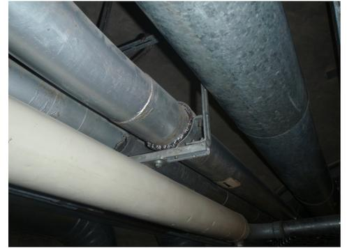
Photo Asbestband bei Rohthalterung
