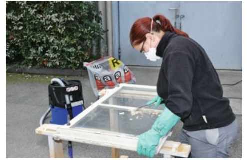
Entfernung eines asbesthaltigen Kitts mit Handwerkzeugen, Suva
