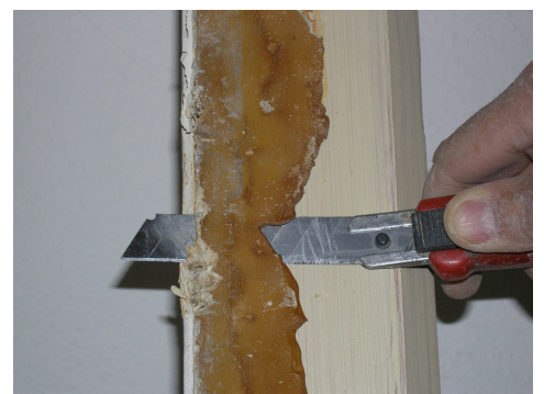
Anschlagkitt entfernen, Suva
