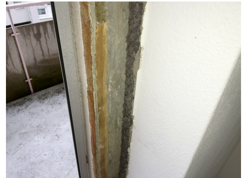
Anschlagkitt ist manchmal tief zwischen Zarge (Fensterrahmen) und Mauer eingefügt. Am besten von aussen her durch das Aufschlagen des Fassadenmörtels einsehbar. Photo A. Pfister, Jäckli AG
