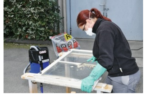
Entfernung eines asbesthaltigen Kitts mit Handwerkzeugen, Suva
