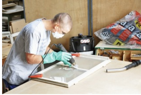
Entfernung eines asbesthaltigen Kitts, wärmebasiertes Verfahren, Suva
