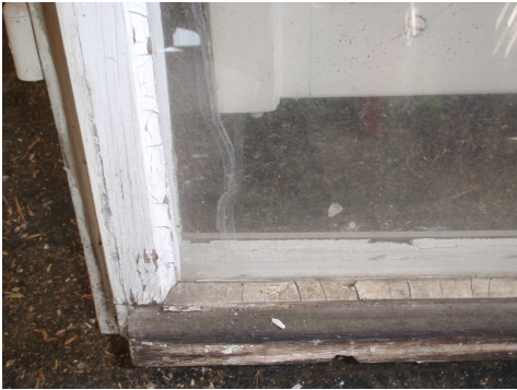
Fensterkitt Holzrahmen doppelverglast, Suva
