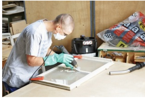
Entfernung eines asbesthaltigen Kitts, wärmebasiertes Verfahren, Suva
