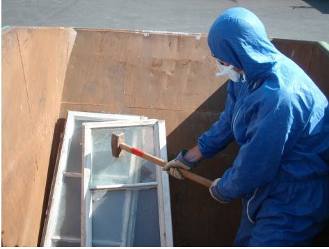
Ausglasen von Fenstern mit asbesthaltigem Kitt im Freien, Suva
