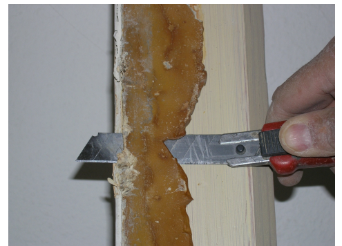
Anschlagkitt entfernen, Suva
